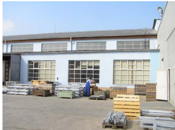
Skladovací plochy – venkovní přístroje
