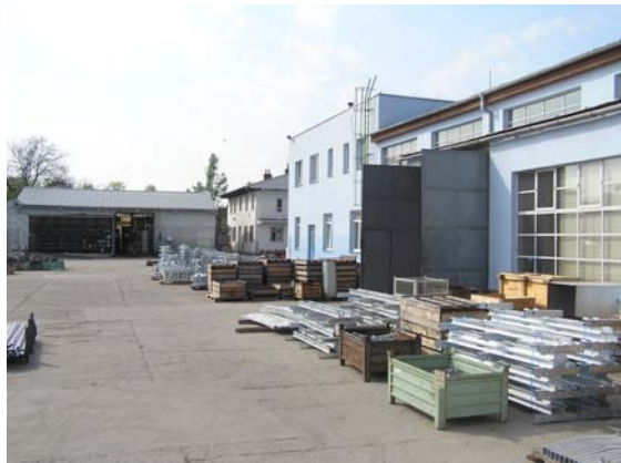
Skladovací plochy – venkovní přístroje
