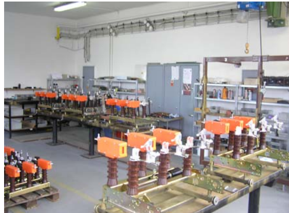
Dílny – montáž vnitřních přístrojů
