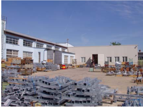
Skladovací plochy – venkovní přístroje
