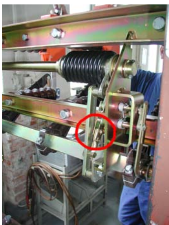
Umístění prolamovací páky na přístroji (pohled zezadu)
