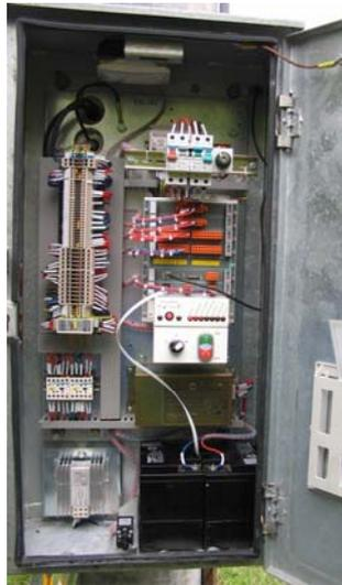
Die Fernsteuerung der Freiluft-Leistungsschalter stellt die Ergänzung des Systems der Fernsteuerung der Lasttrennschalter und Trafostationen in den MS-Distributionsnetzen 22 kV um ein neues Schaltelement dar, das fähig ist, die Kurzschlussströme und Erdverbindungen verbunden mit einem geeigneten komplexem Schutz zu trennen.
